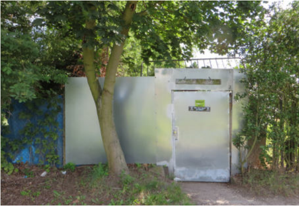
Stark verbarrikadierter Eingangsbereich
