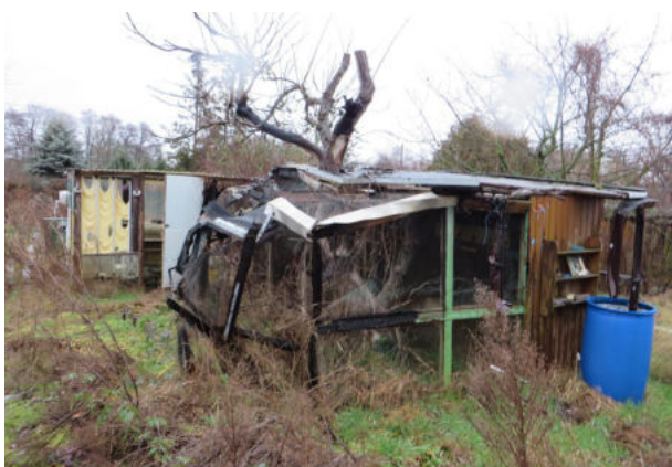
Verwahrloste und vermüllte Gärten z.T. mit abgebrannten Lauben (Westteil)
