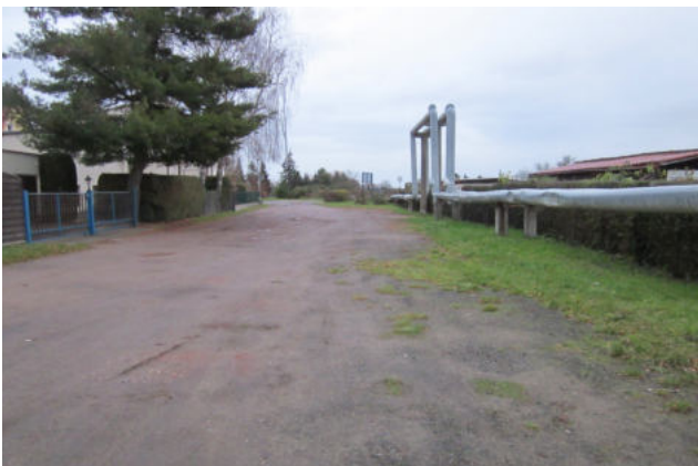
Große Freiflächen am nördlichen + südlichen Ausgang dienen als Parkflächen
