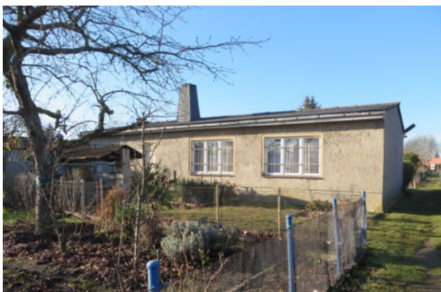
Vereinsgebäude mit Saal, Küche und Sanitäreinrichtung
