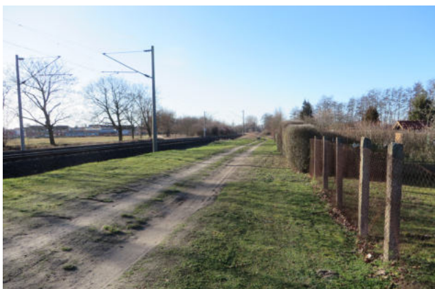
Äußerer Erschließungsweg an Südseite der KGA An der Ihle
