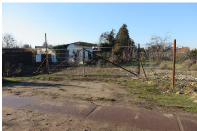
Leerstand wird zu Stellfläche mit großer Zufahrt umgebaut
