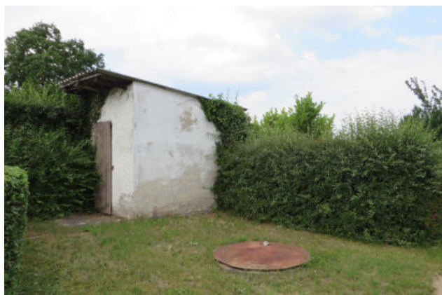
Brunnenhäuschen für eigene Brauchwasserversorgung
