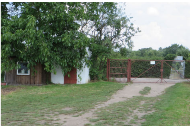
Einfahrt von Leo-Tolstoi-Str. mit Pumpenhaus und Geräteschuppen
