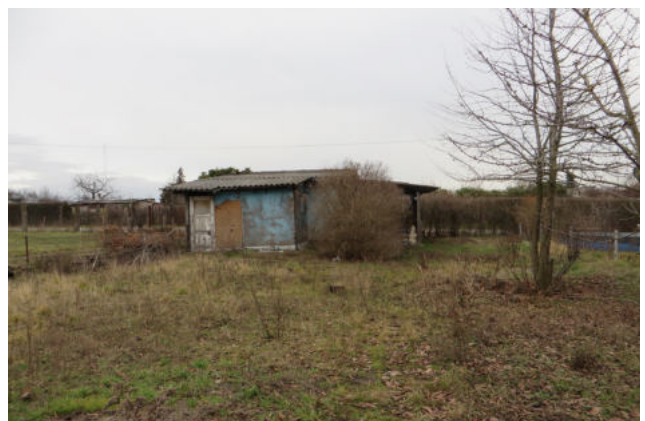
Leerstände in den Randbereichen, Lauben in schlechtem Zustand (Asbest)
