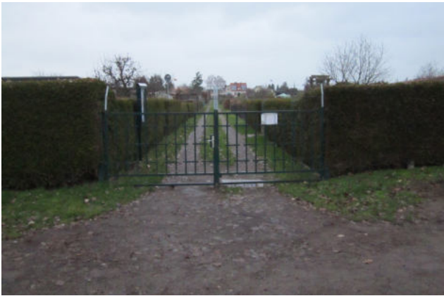
Stabile Tore sichern die Einfahrten zu den beiden Erschließungswegen
