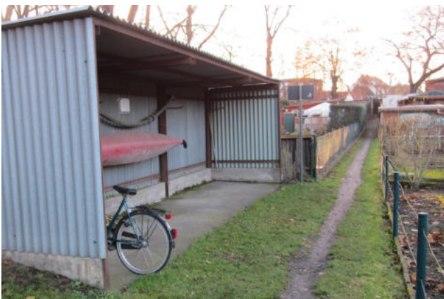
Südlicher Zugang mit Fahrradstellplatz
