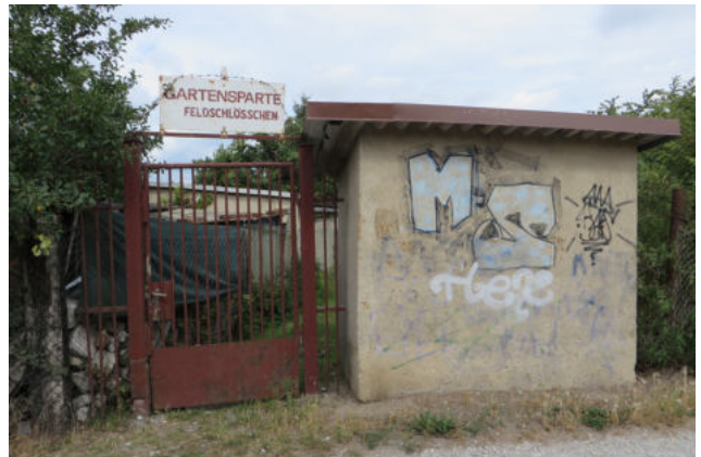
Eingangstür auf Südseite des nördlichen Teils (Standort Leo-Tolstoi-Str.)
