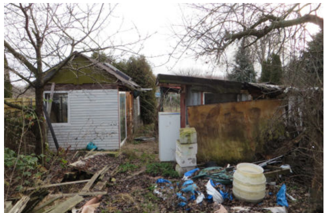
Ungepflegter Problemgarten mit ungeklärten Pachtverhältnissen (Westseite)
