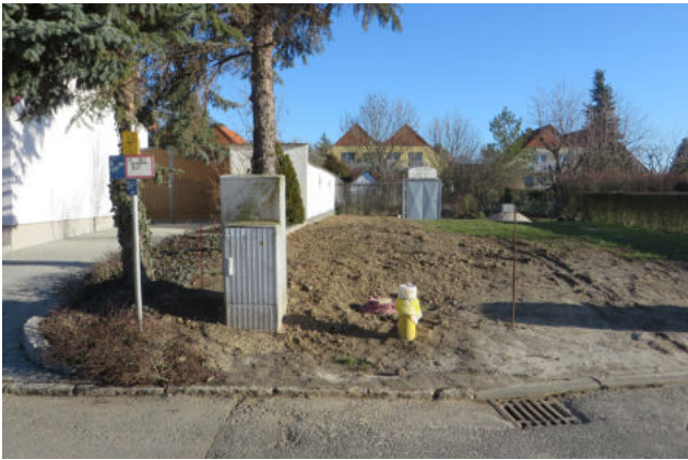
2019 neue Anschlüsse Wasser + Strom, 2020 neue Einfahrt zur KGA + Parkplatz
